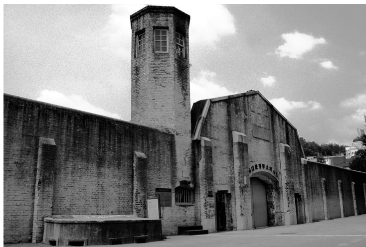
日本により近代化された西大門刑務所。現在は日本の残虐性を象徴する記念館になっている。
